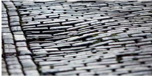
*Adoquinado hundido por el paso de vehículos*
