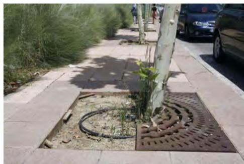
*Imagen ilustrativa de protección metálica robada.*
