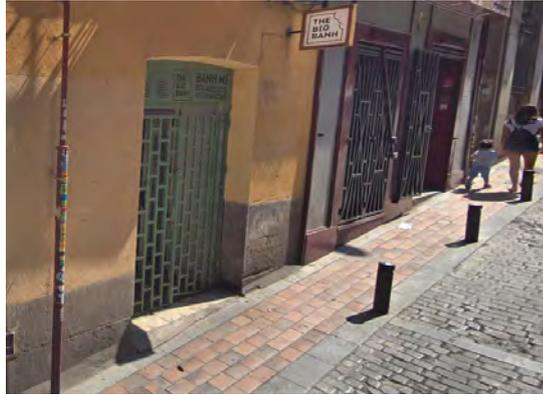
*Imagen de locales comerciales con distintas alturas, que generan escalones inaccesibles*
