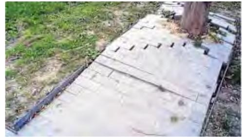
*Imágenes ilustrativas de pavimentos de adoquín y de aglomerado asfáltico, levantadas por las raíces de los árboles*
