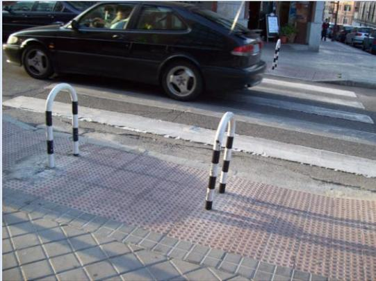
*En la imagen se observa la señalización en el pavimento que advierte de la proximidad de un paso de cebra. La señalización escogida es una textura rugosa (círculos que sobresalen) y un color de contraste (rosa) que genere contraste.*
