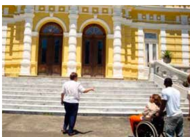
Figura 2. Acceso principal al Palacio de Rio Negro en Petrópolis
